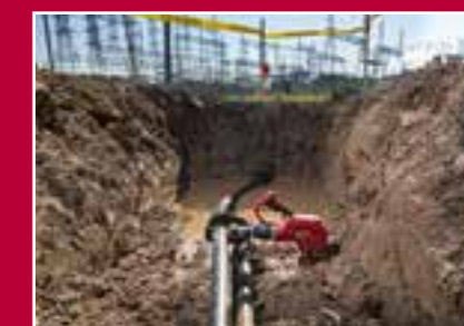
Design studiato per un accesso facilitato all'interno degli scavi
